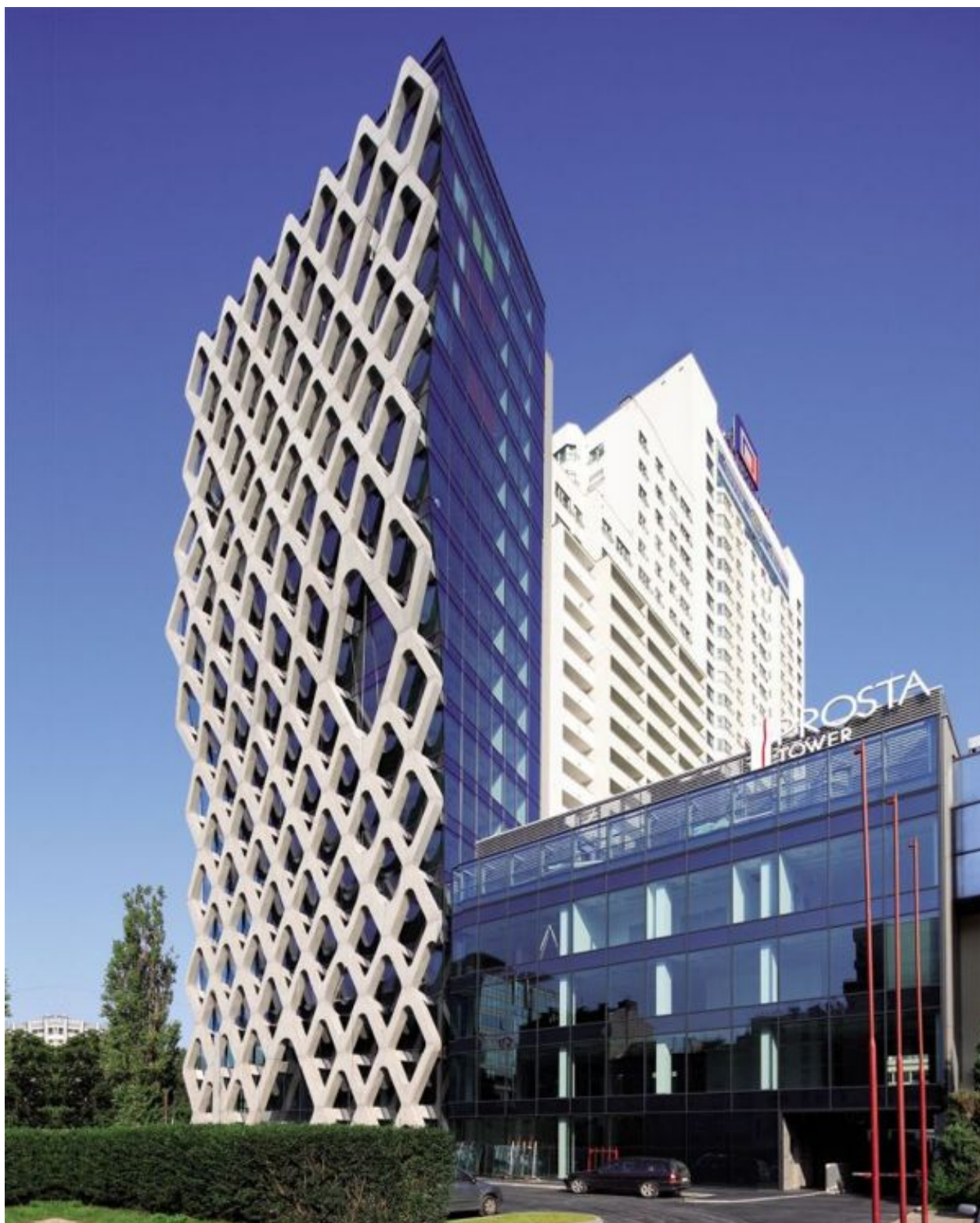
fot. ALUPROF: Prosta Tower - elewacja
