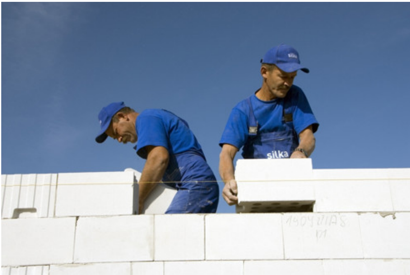
Murowanie wytrzymałej ściany z bloków SILKA
