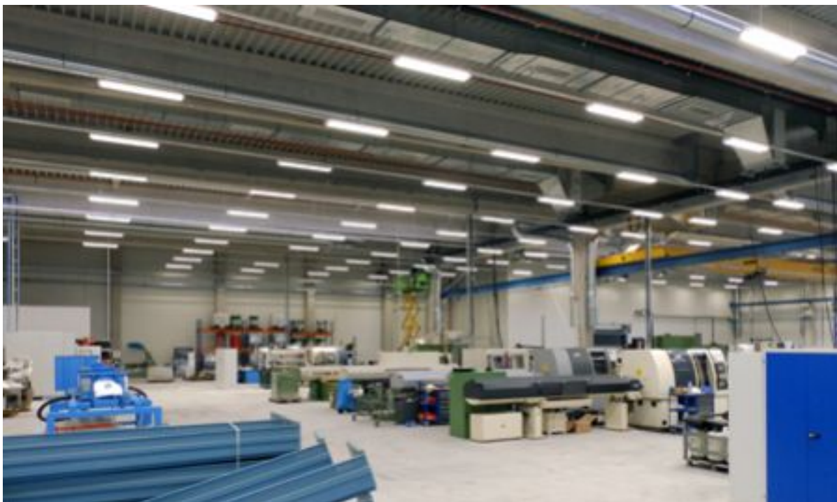
Zdjęcie 4: Dzięki szybkiemu postępowi prac pierwsi pracownicy przenieśli się do nowego zakładu już w styczniu 2014. Foto: Winkhaus
