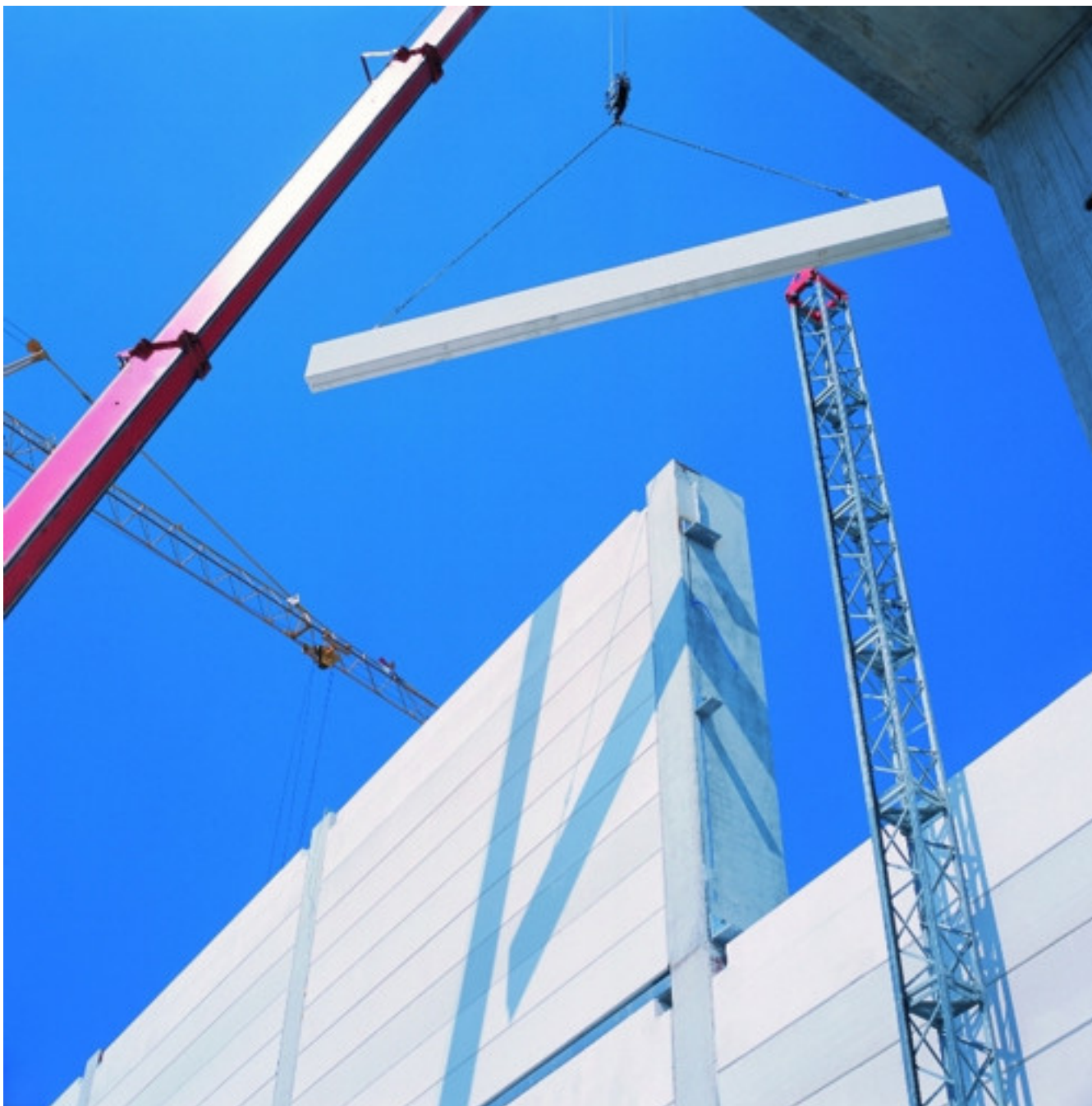
Montaż elementów zbrojonych YTONG
