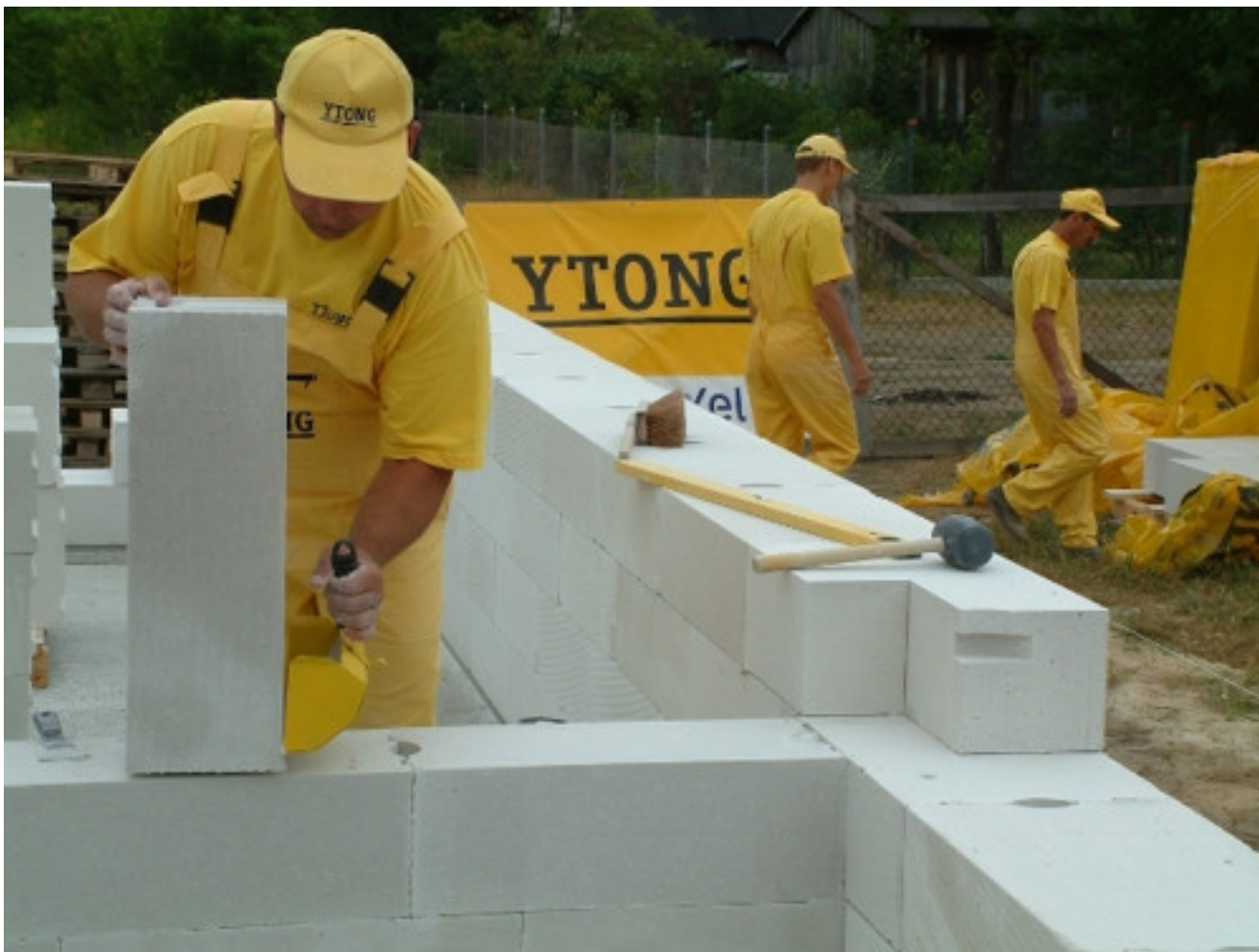
Murowanie na cienką spoinę
